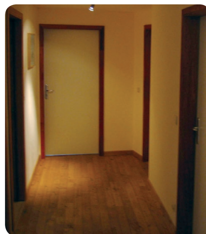
Revêtement non glissant.
