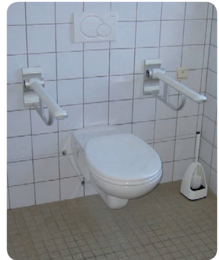
Placement de barres d'appui dans W.-C. adapté.
